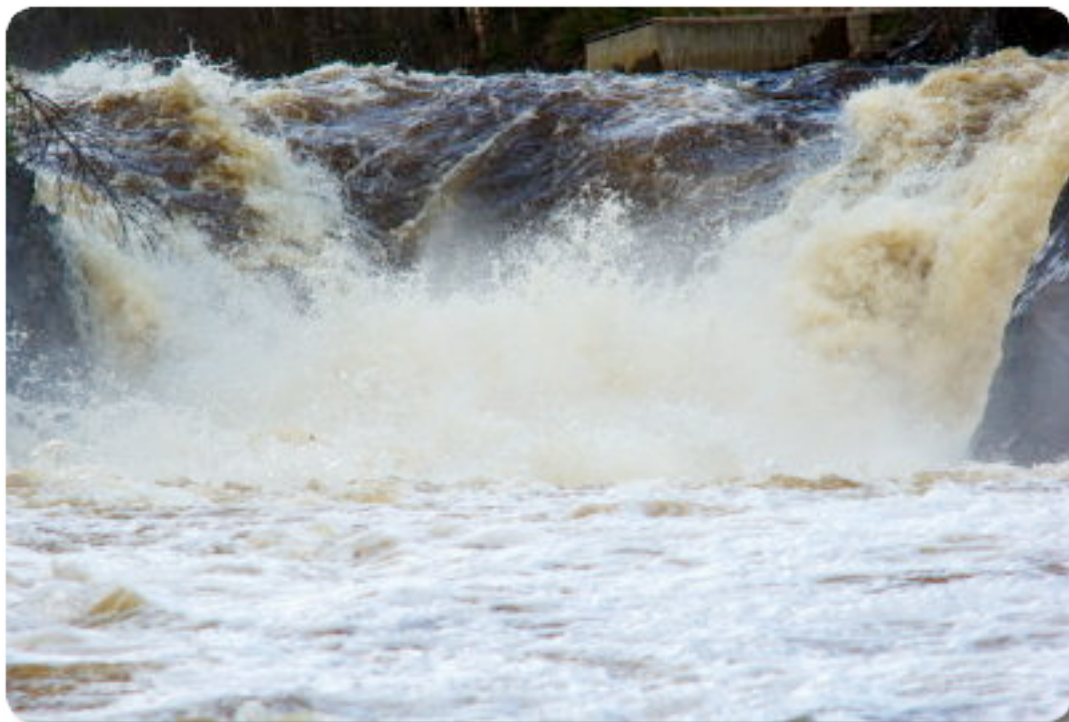
Lögdeälvens högsta vattenfall finns i Fällforsen. Fisktunnelns mynning skimtar i form av ett betongfundament i bakgrunden.
